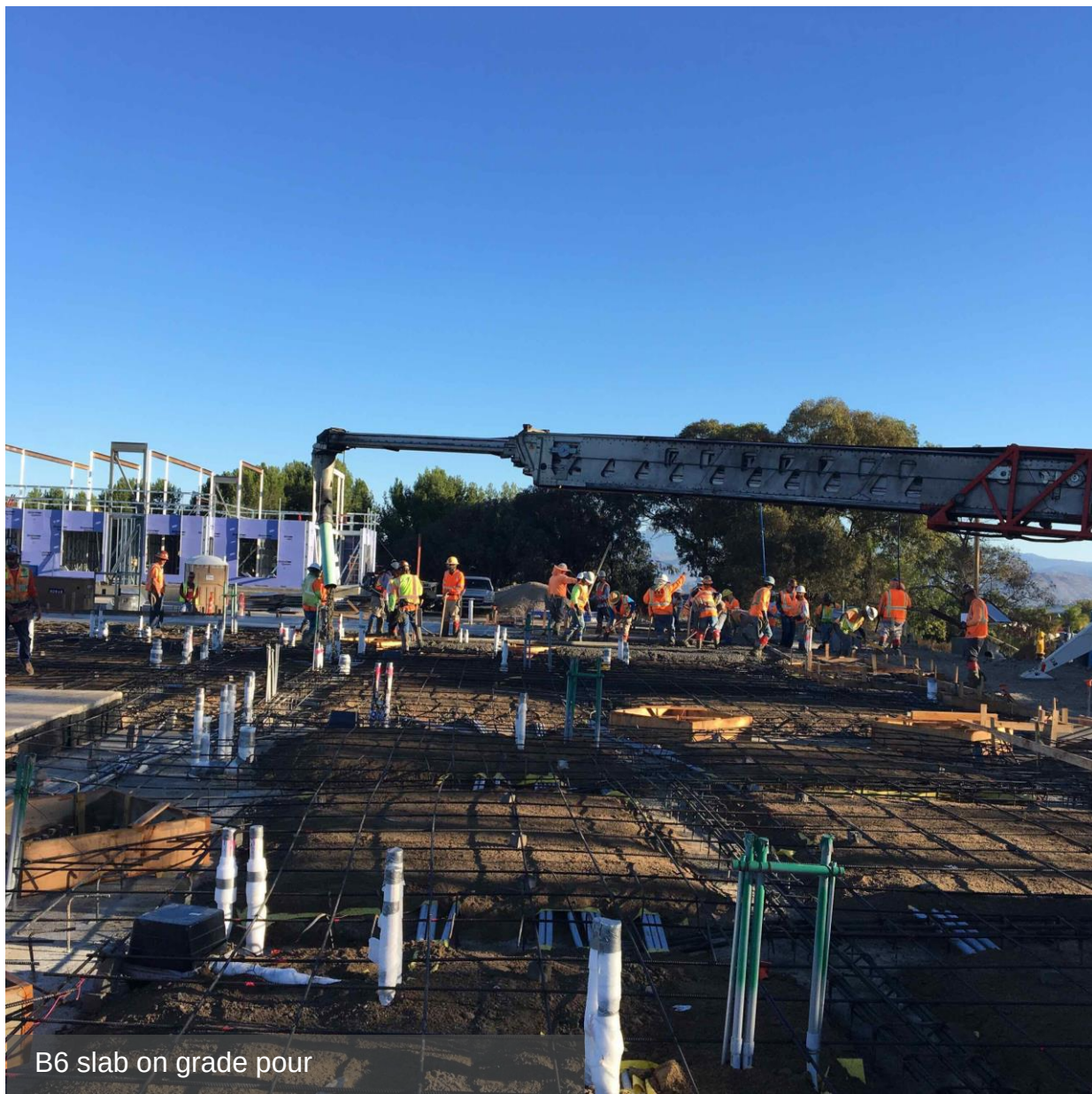
B6 slab on grade pour
