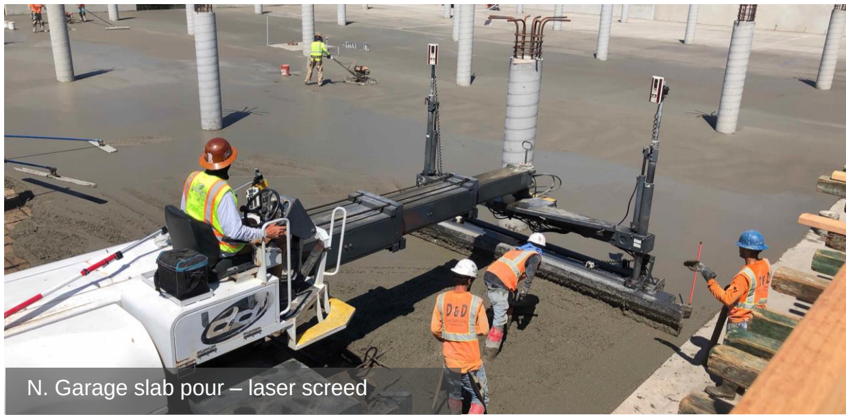
N. Garage Slab pour – laser screed
