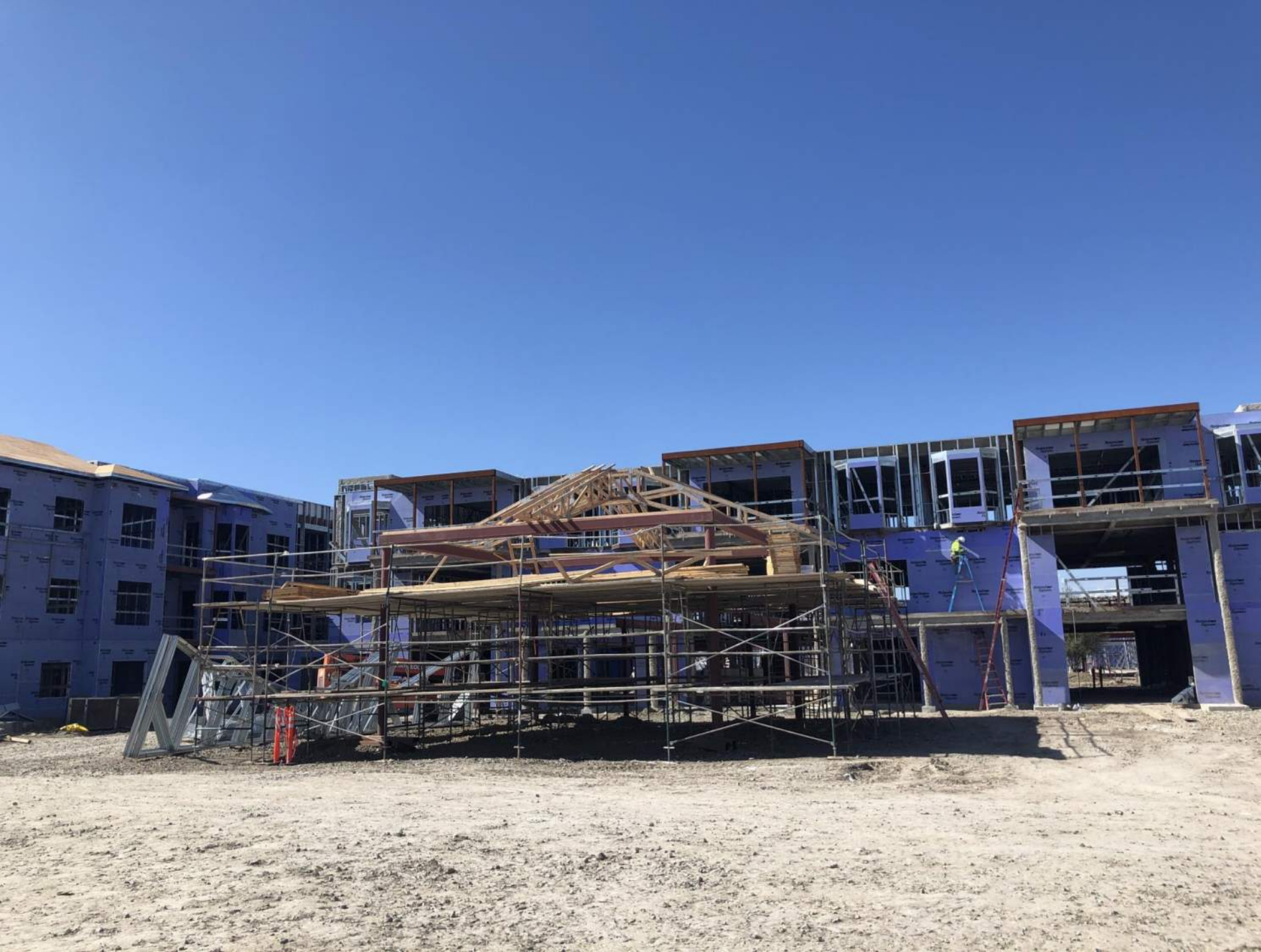
Porte Cochere Trusses
