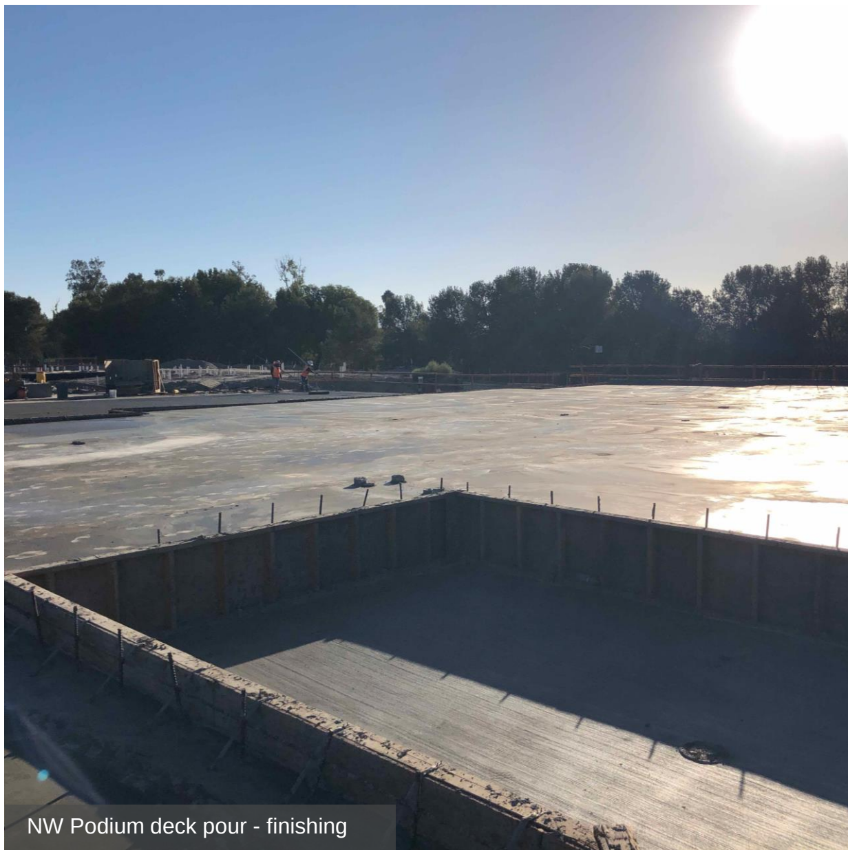
NW Podium deck pour - finishing
