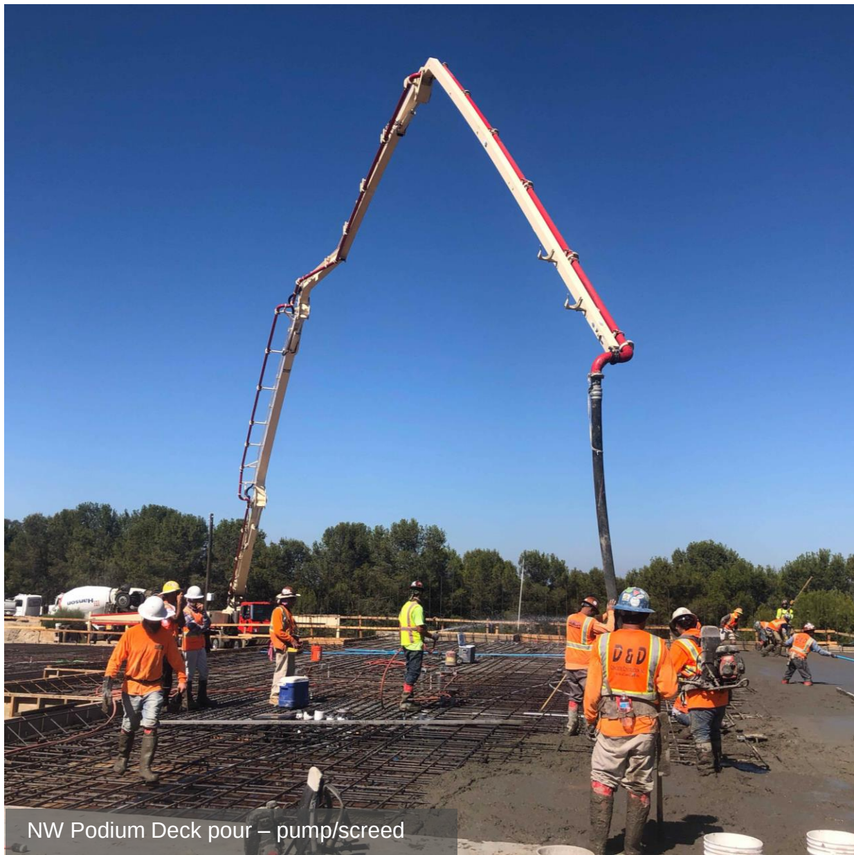
NW Podium Deck pour – pump/screed
